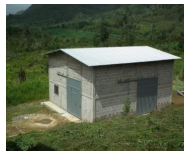
Bodega y oficina de la Central de Beneficiado Ecológico de Café Proyecto/COMIXPLANL en El Paraíso
